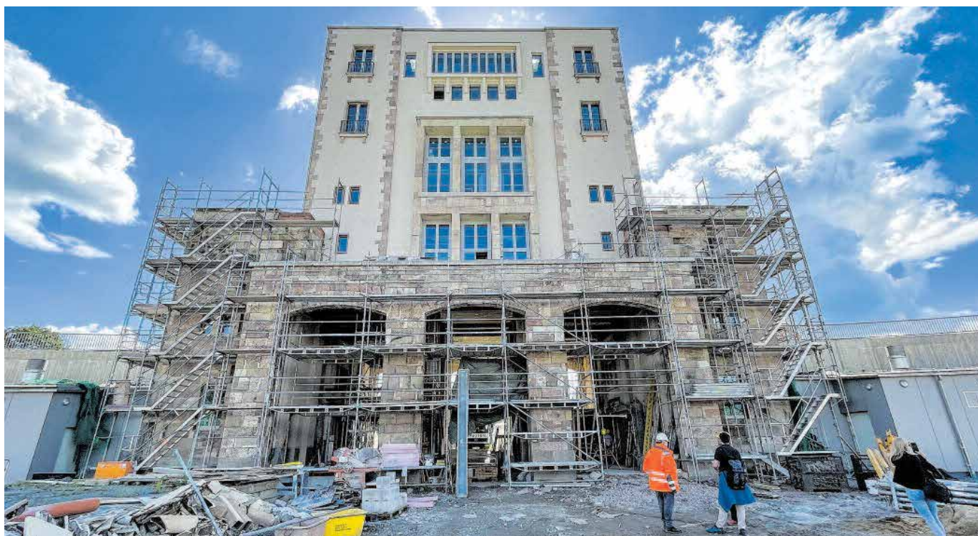
Seit Juli 2020 wird der 27 Meter hohe Marthonturm im Sportforum saniert. Mit dem Abbau des Bagerüsts sind die Arbeiten allerdings noch nicht abgeschlossen. Foto: Philipp Köhler
