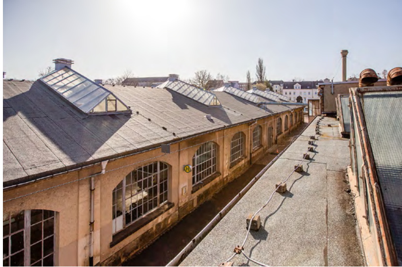
Hier entsteht der Garagen-Campus: Anfang März haben die Arbeiten begonnen. Foto: CVAG
