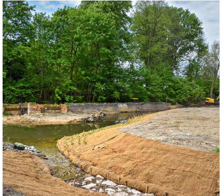
Das Bachbett des Pleißenbachs wird an vielen Stellen wieder natürlicher angelegt, der Bach bekommt dadurch mehr Raum und wird so zu einem wichtigen Lebensraum für viele Tier- und Pflanzenarten. Foto: Franziska Fiedler
