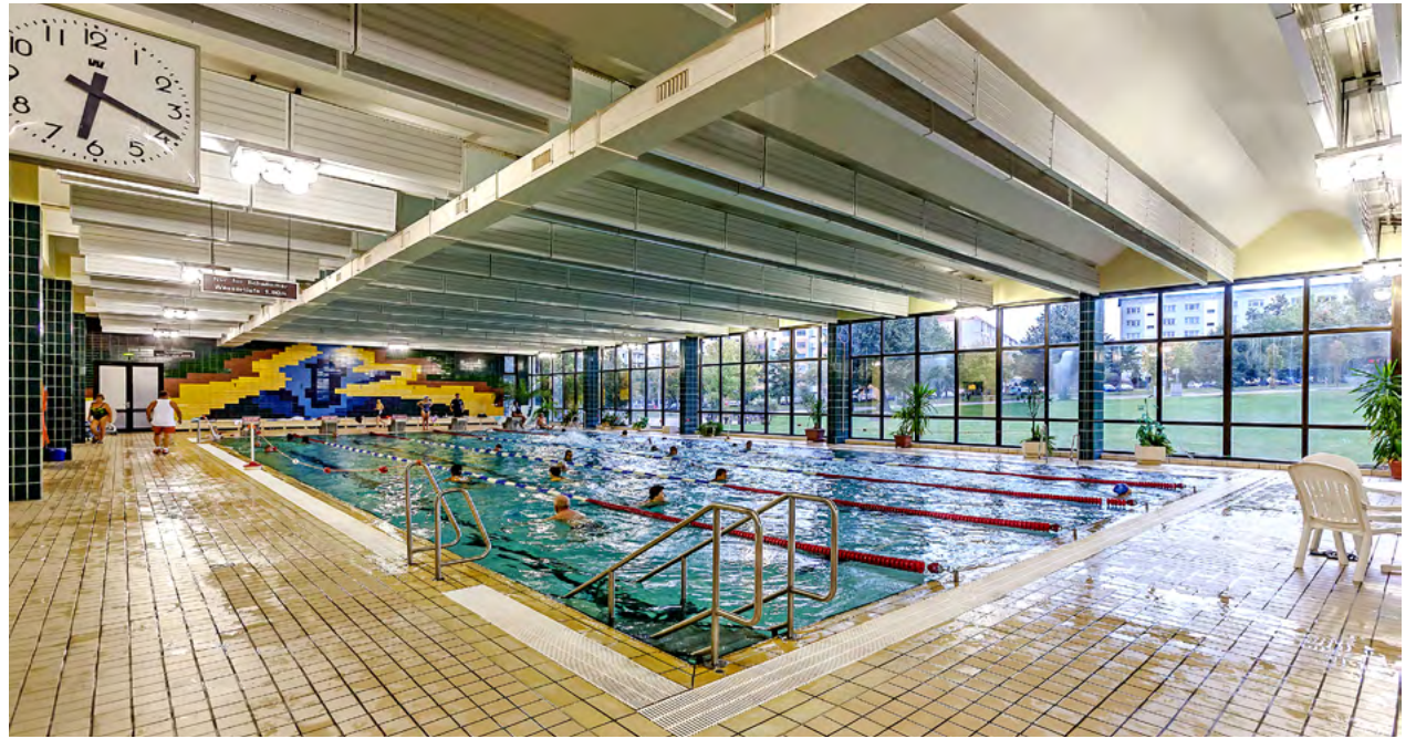
Mit dem Beschluss des Stadtrates wird die Schwimmhalle »Am Südring« nun von Grund auf saniert: mit neuer Technik, einer energetischen Sanierung sowie erneuerten Schwimmbecken und Leitungen. Foto: Stadt Chemnitz
