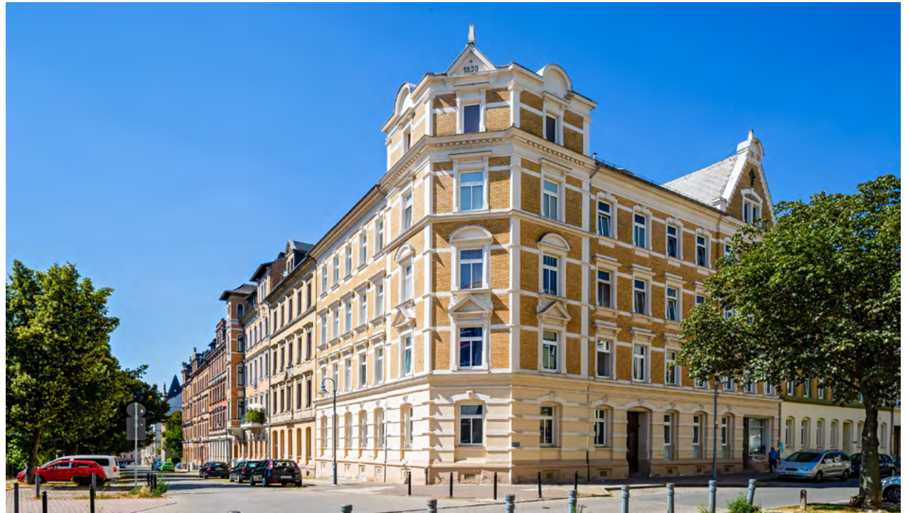
Ein Teil der neuen EFRE-Fördermittel soll in die Umgestaltung der Achse Markusstraße auf dem Sonnenberg fließen. Foto: Stadt Chemnitz/Dirk Hanus
