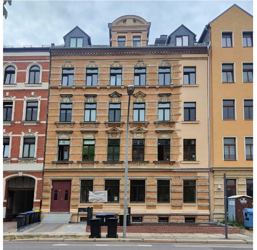
Nach der Sanierung erstrahlt die Fassade in hellen Farben.
