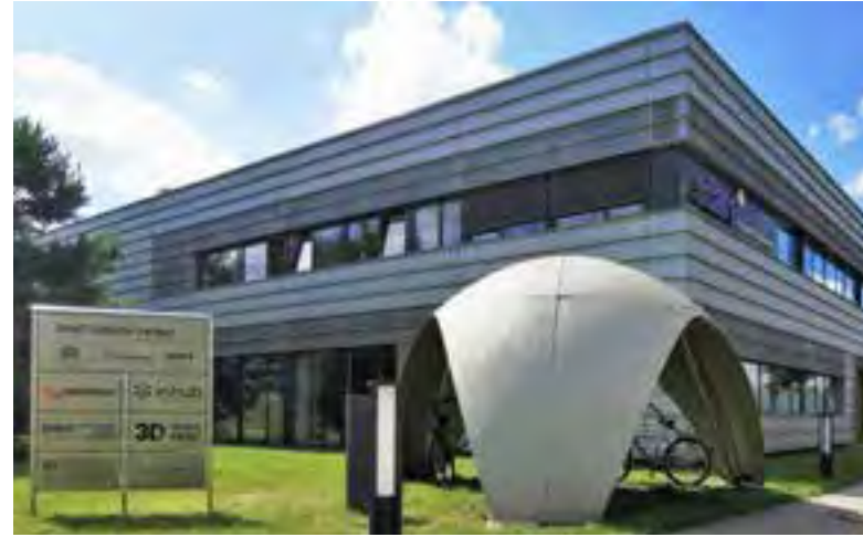
Start-up Gebäude am Technologie-Campus
