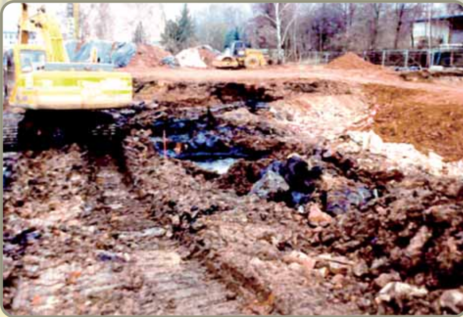
Abb. 20: Teergruben und Randbereich des wiederverfüllten Gasometers
