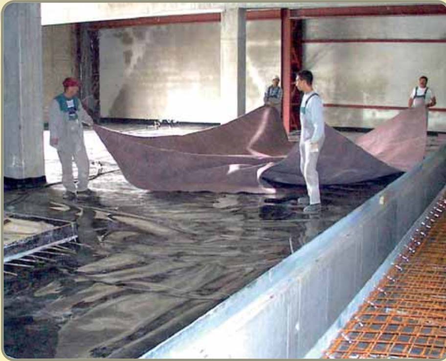
Abb. 16: Einbau gasbeständiger Folie
