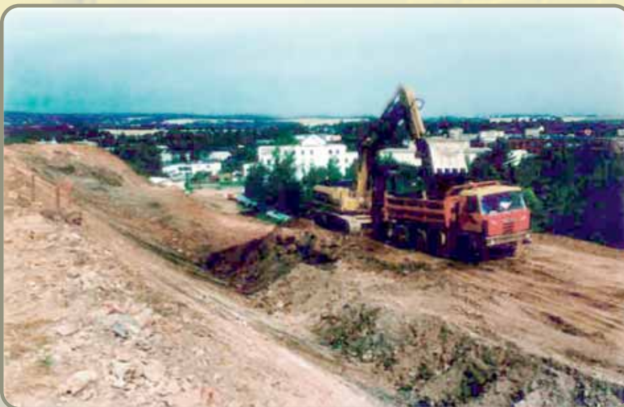
Abb. 24: Umlagerung von Deponat im Rahmen der Böschungskonturierung
