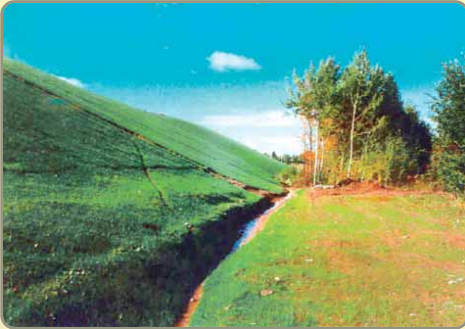
Abb. 25: Abgeflachte und begrünte Nordost-Böschung
