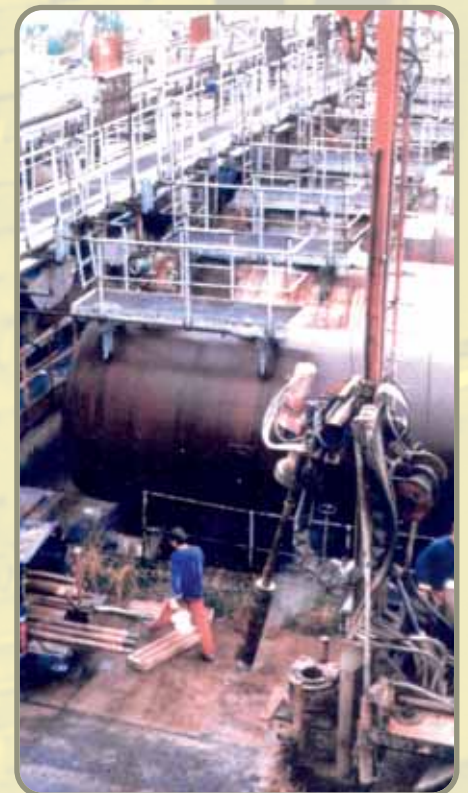
Abb. 21: Bereich mit 50 oberirdischen Tanks mit Fassungsvermögen zwischen 25 und 50 m 3
