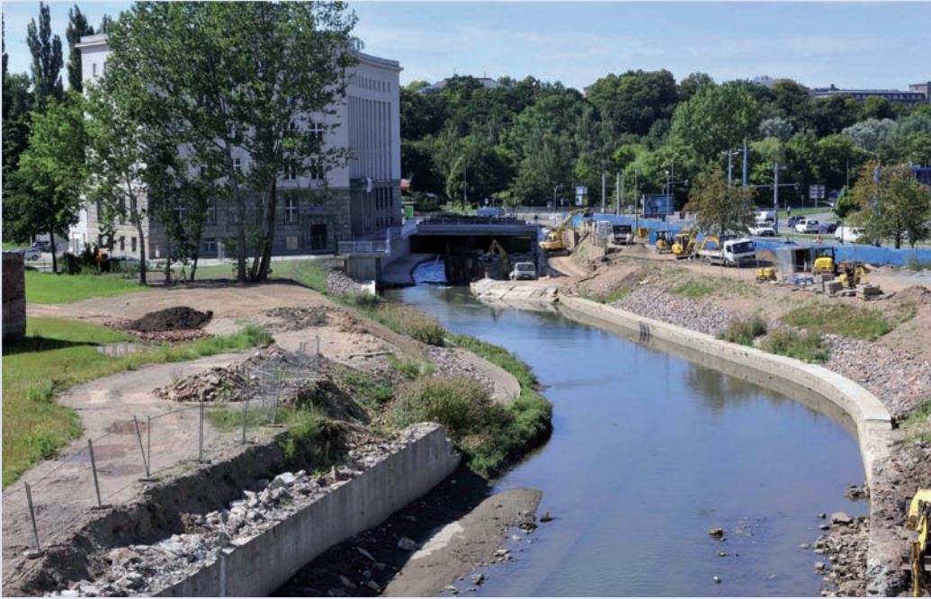
Abbildung 6.3: Freilegung der Chemnitz (Foto: Schmidt, Amtsblatt 12. August 2009)
