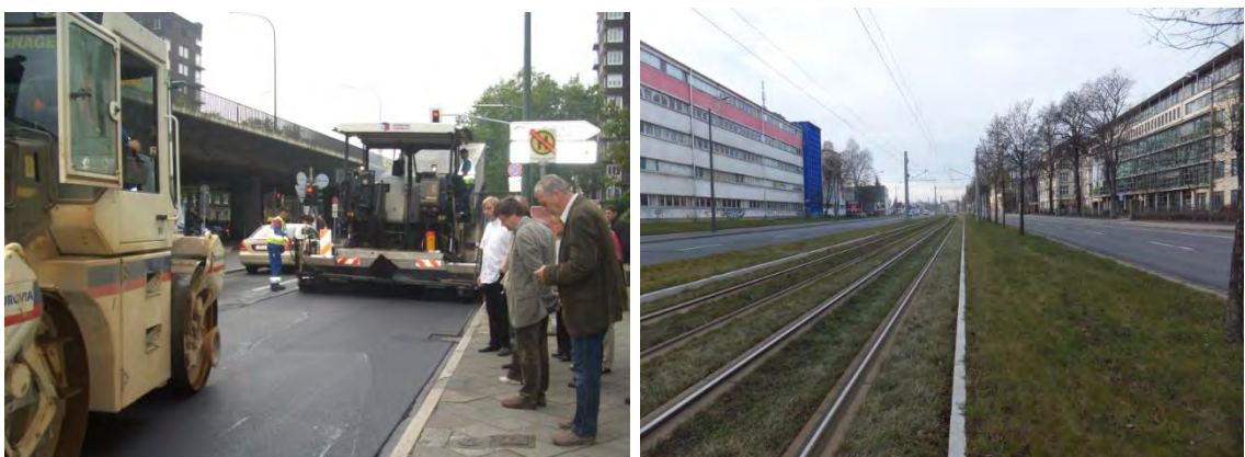
Fotos: Einbau lärmindernder Belag in Düsseldorf, Rasengleis Zwickauer Straße Chemnitz
